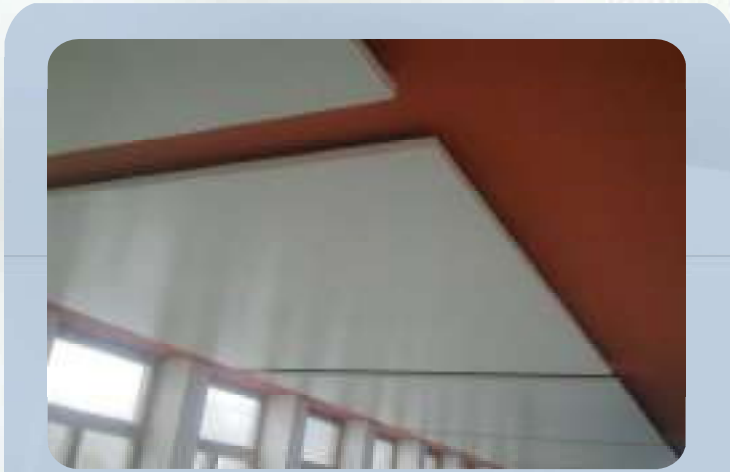
MCS.a offenes Kühl- / Heizsegel zu Inseln angeordnet
