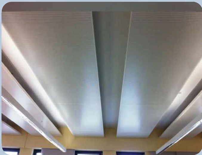
MCS.s offenes Stahlblech Kühl- u. Heizsegel
