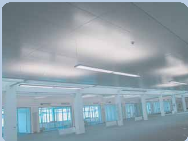
MCC-A.s Metall-Kühldecke in Auflegetechnik
