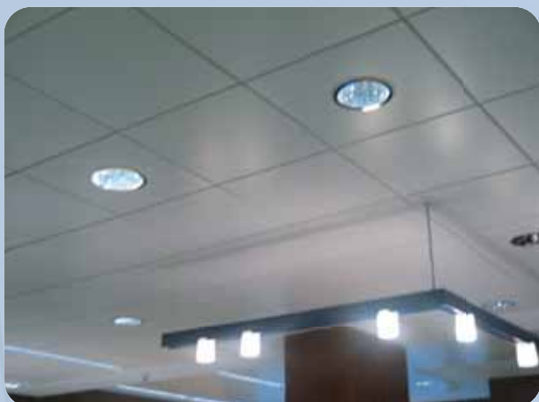
MCC-E.s Metall-Kühldecke in Einlege-technik
