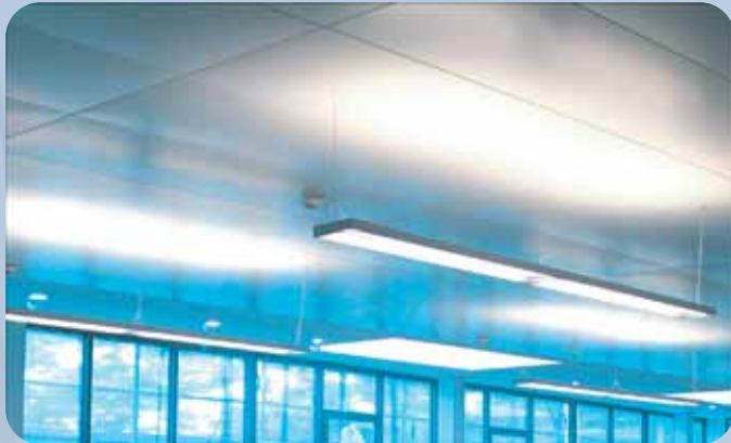
MCC-K Metall-Langfeldplatten-Kühldecke in Klemmtechnik
