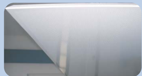
Kühl- / Heizsegel mikroperforiert
